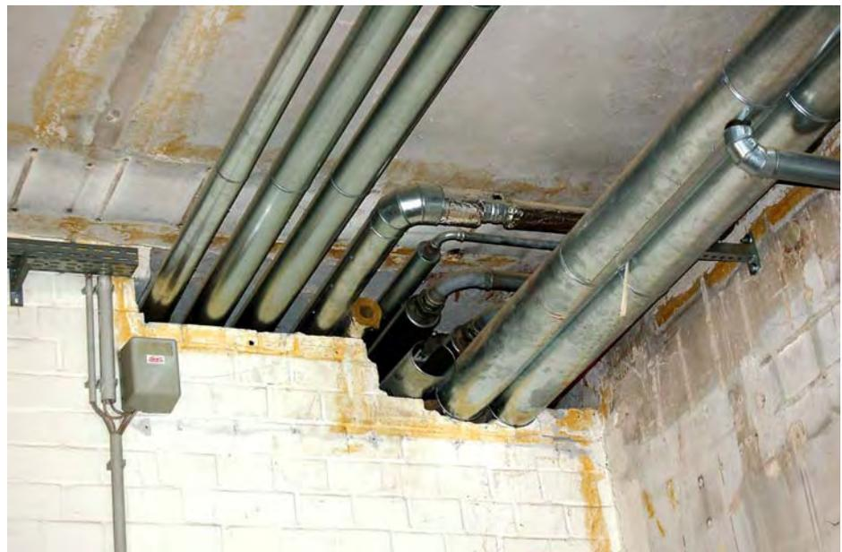
Umgehend müssen im Keller diverse offene Durchbrüche an Decken und Fluren feuerbeständig verschlossen sowie die offen liegenden elektrischen Leitungen ummantelt werden. Diese Durchbruchlöcher bedeuten im Falle eines Brandes eine erhebliche Gefahr, da ein Übergriff auf das darüber liegende Hauptgebäude wahrscheinlich wäre.
