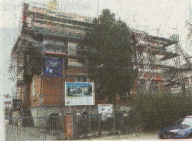
Schon im Jahr 2010 begann der Ausbau der Max-von-Laue-Schule
